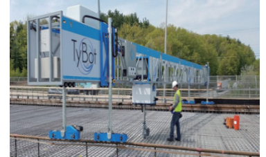
• TyBot (미국, Advanced Construction Robotics), 6~8명 작업자를 1명이 대체
